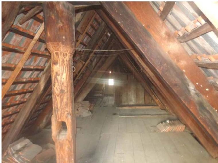
Über dem Rückgebäude sitzt ebenfalls ein 2-geschossiger Dachstuhl aus vermutlich teilweise zweitverwendetem Nadelholz (Kehlbalken, Pfetten) mit nachträglichem stehenden Stuhl und hauptsächlich gezapften Verbindungen (u.a. Sparren-Kehlbalken). An der Westseite ist neben dem alten Stuhlrähm eine nachträgliche Hilfspfette mit Stütze und Schwelle eingebaut.
