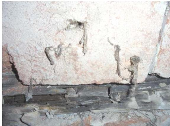
Die meisten Innenwände sind kaum gegründet. Sie enden 20-40 cm unterhalb des jetzigen Bodenniveaus, meist ohne verbreitertes Fundament auf weichem, breiigem Boden.
