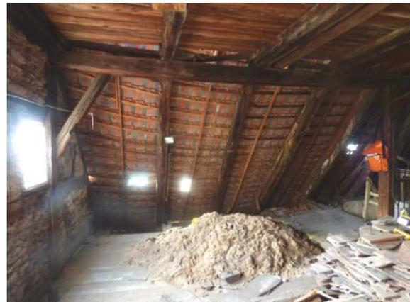
*Offener Anschluss am Dachfuss Zerrbalken -Sparren*      *durchgebogenes Rähm*
