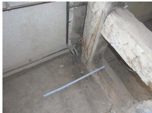
Die Innenwand im Erdgeschoß des Rückgebäudes zwischen Keller und vermutlich ehem. Stall ist eine Massivwand, auf der über dem Kellerscheitel eine Fachwerkwand aufgesetzt wurde.
