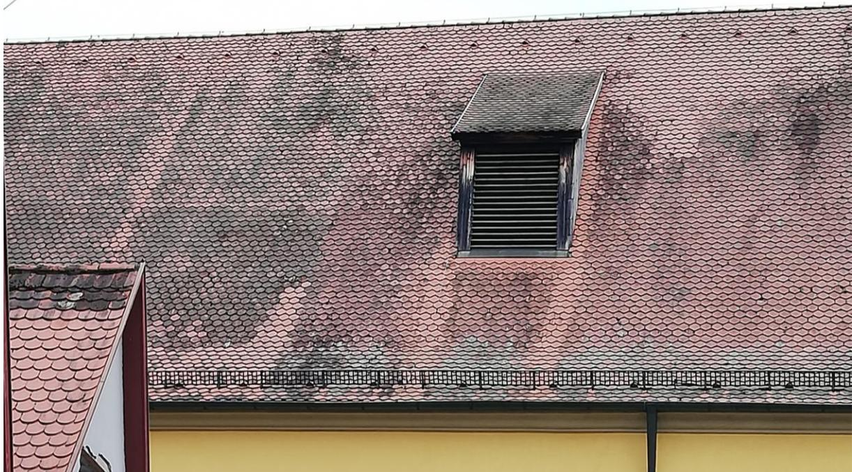
Für die umfangreiche Lüftungstechnik des Hotels und Restaurants werden zusätzlich zur geplanten Öffnung an der Giebelseite weitere Lüftungsöffnungen benötigt. Diese sollen in Form von einer dritten Reihe Gauben auf dem Nord- und Süddach errichtet werden. Die Gauben sind kleiner als die Standardgauben für die Hotelzimmer.
