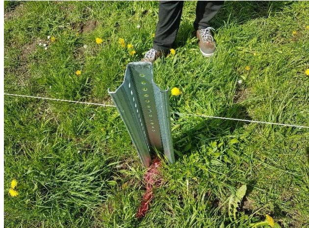
Abbildung 5: Rammfundament
